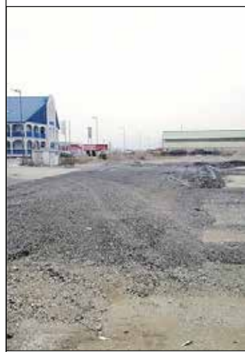
Hier errichtet die Firma Swietelsky ein riesiges Betonfertigungswerk.
