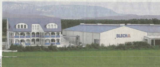
Blecha-Standort in Neunkirchen: Um 4,5 Millionen € entsteht eine neue Lagerhalle
